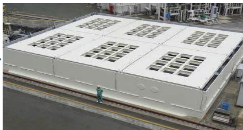
海水ピットポンプ室防護壁設置
