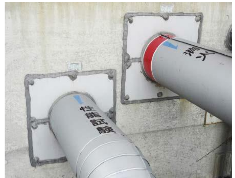
防水シール施工
